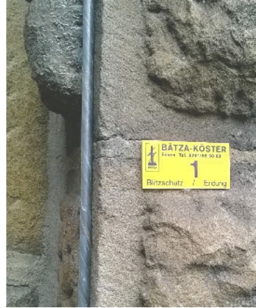
Erdungspunkte sind gut sichtbar markiert
